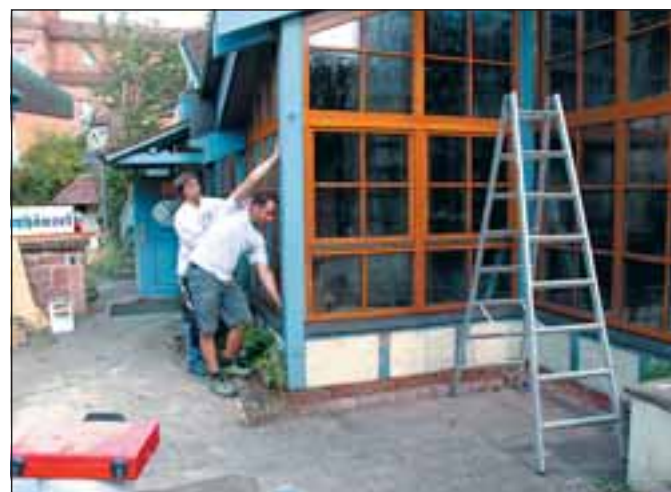
Die Arbeiten am „Bierhäusel“ laufen auf Hochtouren; Ende Oktober soll die Kneipe wieder eröffnet werden. Foto: Weyrauch
